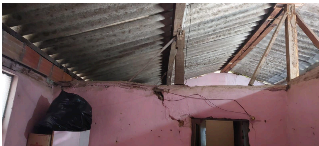
Telhado e instalações elétricas da Casa Paterna Autoria: Maria Leticia Ticle Data: 15/02/2024
